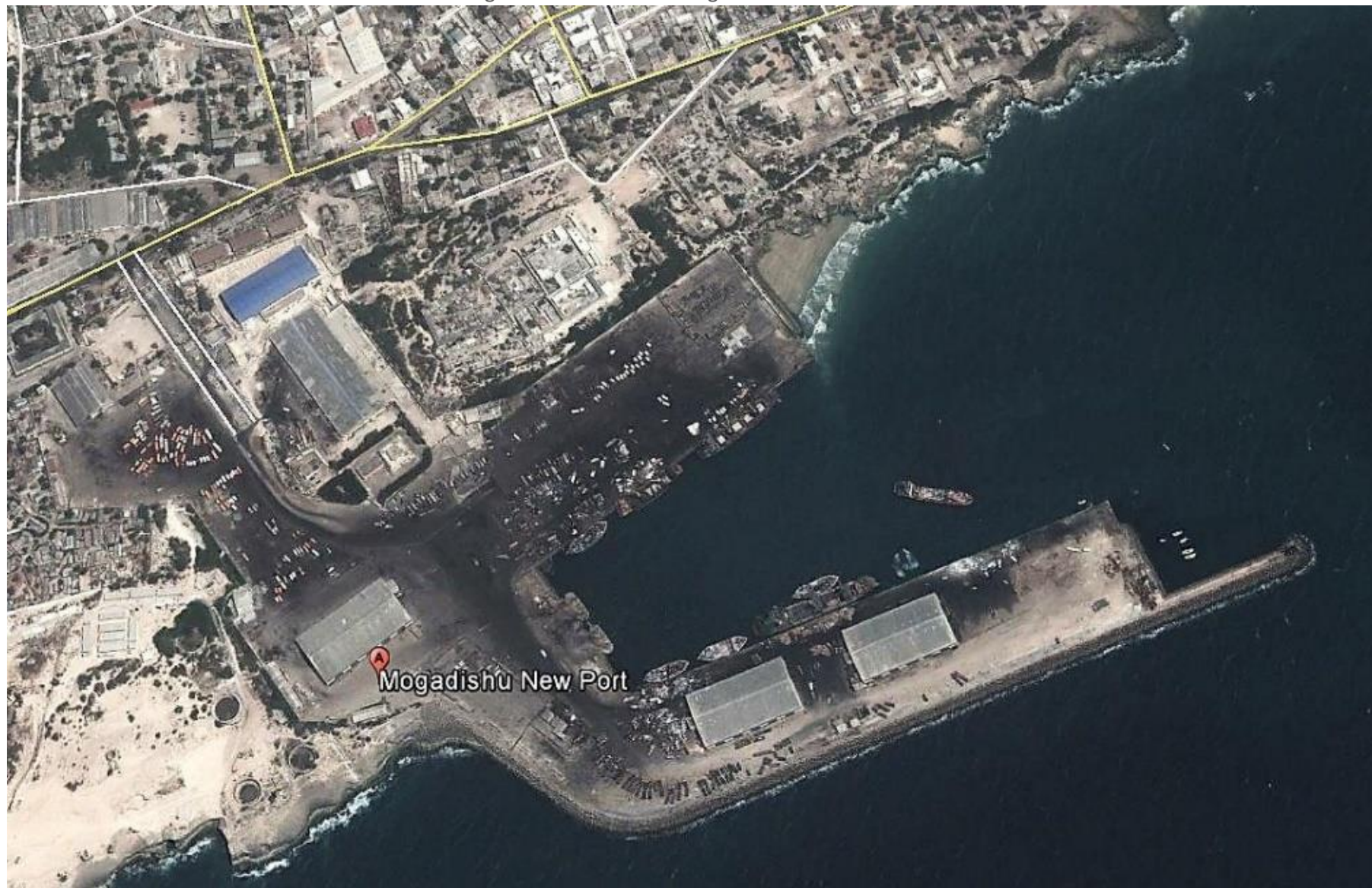
Photos des infrastructures du Corridor de Mogadiscio : Port de Mogadiscio
